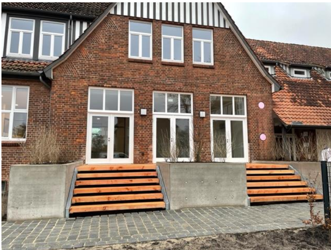
Handläufe werden noch angebracht.
